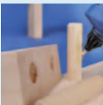
Склеивание деревянных конструкций
