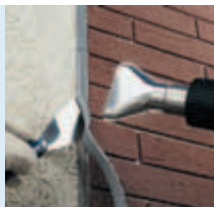
Удаление стыковой замазки
