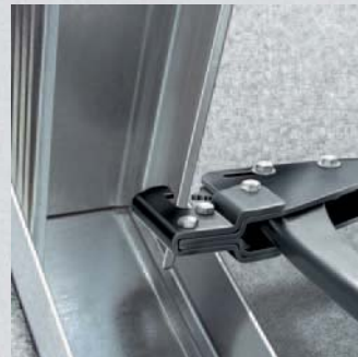
Установка инструмента на оба соединяемых профиля
