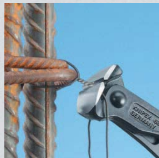
также используются в монтаже арматуры железобетонных конструкций
