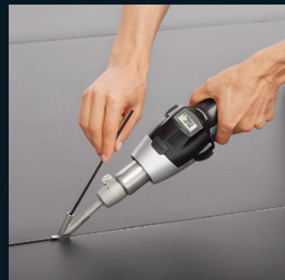
Сварка напольного линолеума
