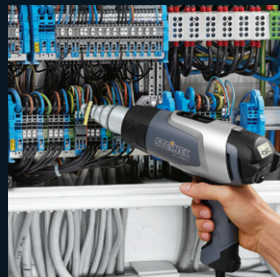
Обжим кабельных муфт в распределительном шкафу
