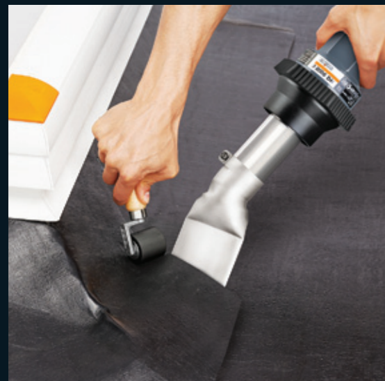
Сварка внахлестку легкого каркаса
