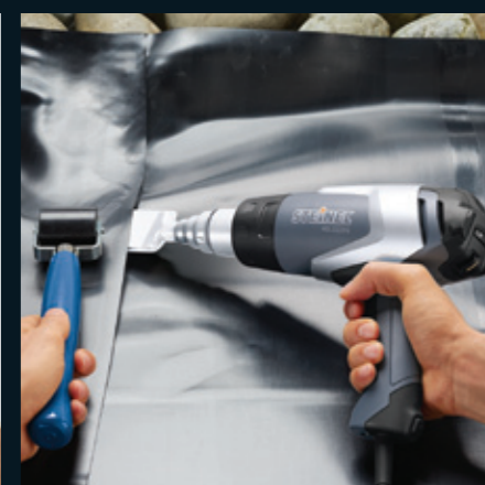
Сварка облицовки бассейна HG 2320 E
